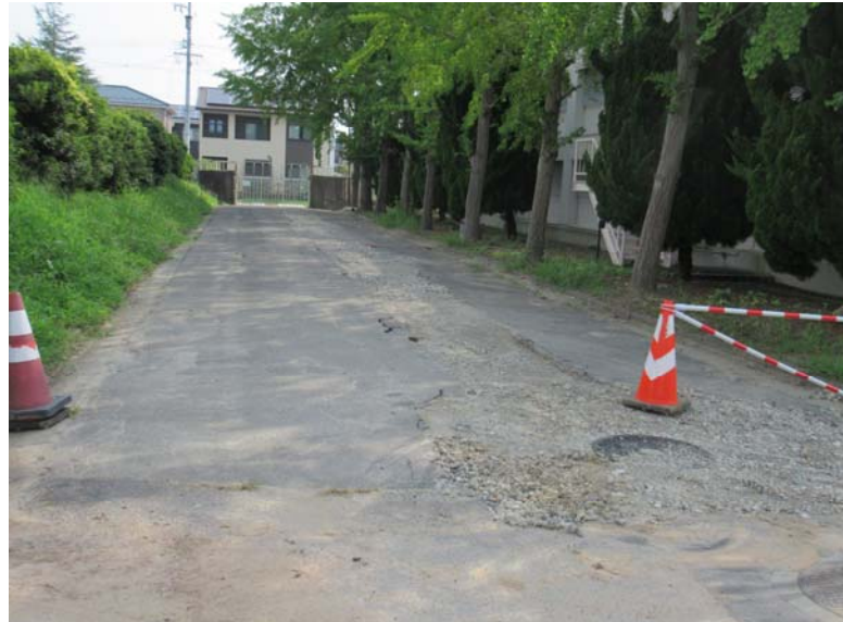
砂利による飛び石、段差による走行注意
