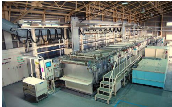
(自動めっき設備)
