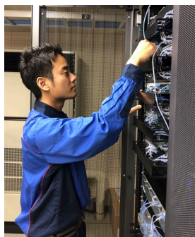
サーバ構築作業
