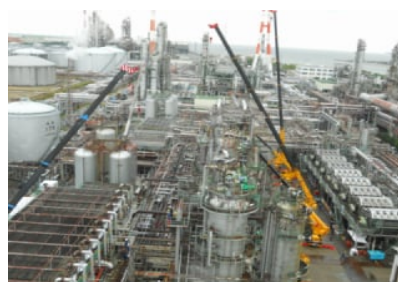
プラント定期修理工事
