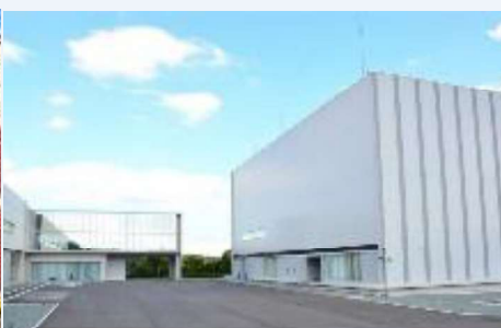
データセンター（津市内）
