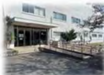
第一体育館 自動ドア・スロープ
