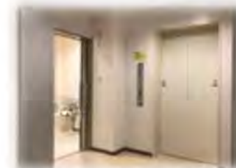
事務・教養棟 EV・多目的トイレ
