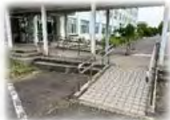
生物応用化学科棟 スロープ
