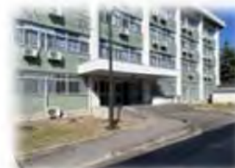
第4青峰寮 スロープ
