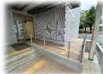
電子情報工学科棟 スロープ・半自動ドア
