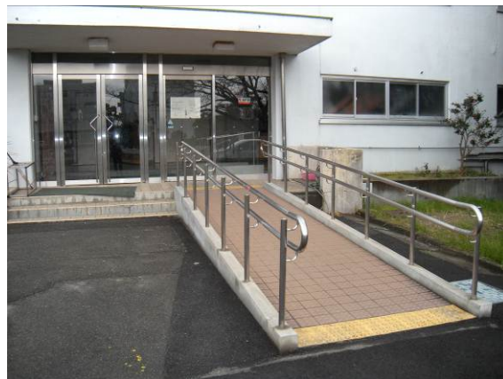
第1体育館スロープ・手すり・自動扉
