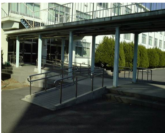
教室棟渡り廊下スロープ・手すり
