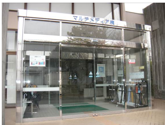
マルチメディア棟自動扉
