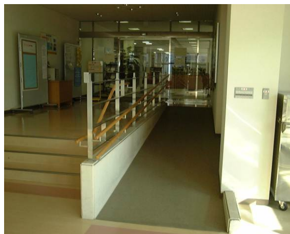
マルチメディア棟内スロープ・手すり
