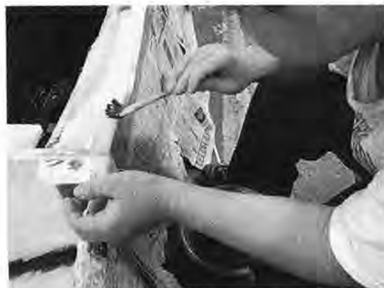
図1 ガラス繊維をエポキシ系樹脂で固着する風景
