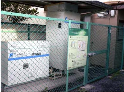
図1 鈴鹿高専における1kW 定置型燃料電池実証試験風景 (PEFC 富士電機社製 2005年5月試験開始)
